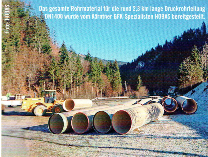
Dank des Schrägschnittsystems von HOBAS konnten weite Teile der Rohrtrasse ohne den Einbau von zusätzlichen Gelenkstücken verlegt werden.
