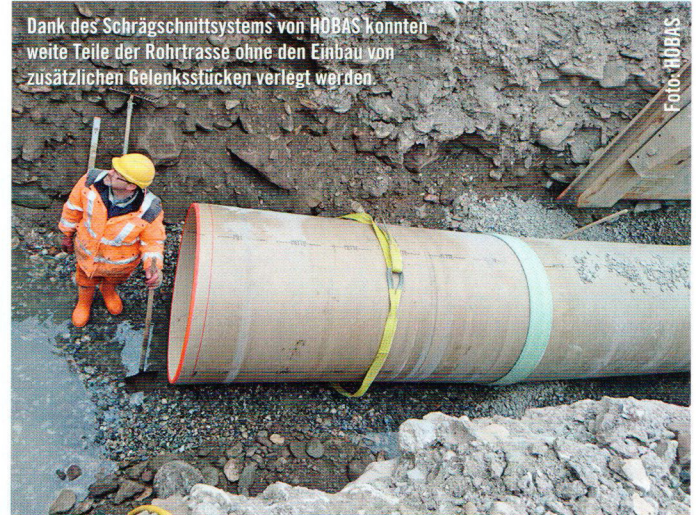
Das gesamte Rohrmaterial für die rund 2,3 km lange Druckrohrleitung DN1400 wurde vom Kärntner GFK-Spezialisten HOBAS bereitgestellt.
