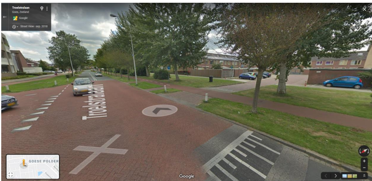
Afbeelding 5: fietspaden bij de t-splitsing van de Laan der Verenigde Naties en de Troelstralaan
