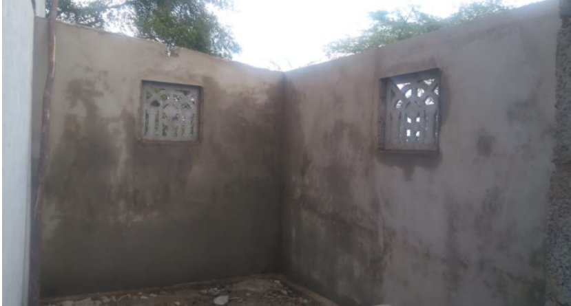
Keukenruimte in opbouw
