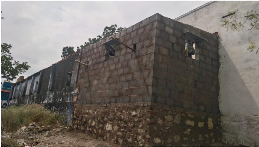
Uitbouw van een keukenruimte
