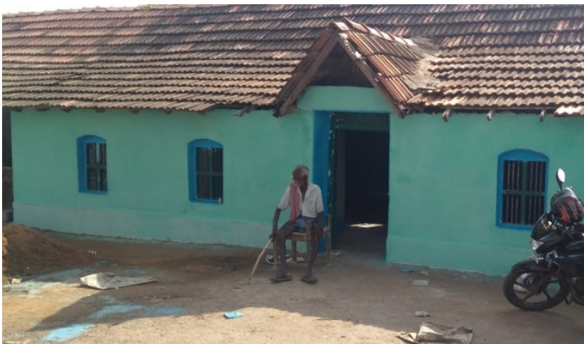
Buitenmuren geschilderd - dak bijna helemaal hersteld
