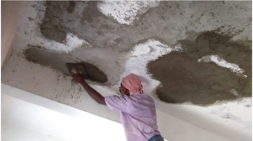
Herstellen van het plafond
