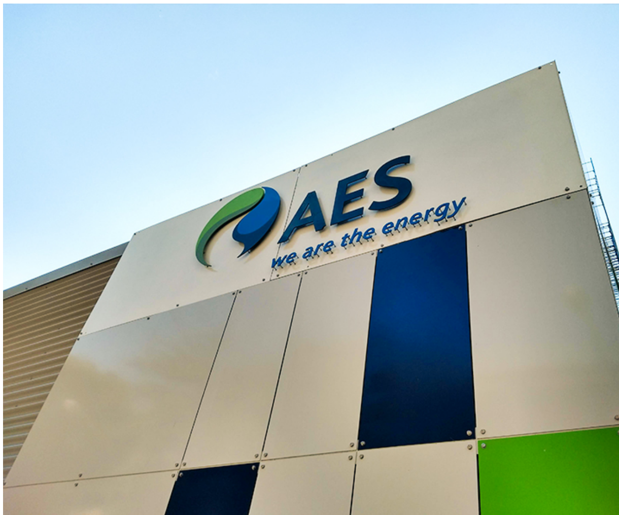
Sistema de baterias AES Tietê
