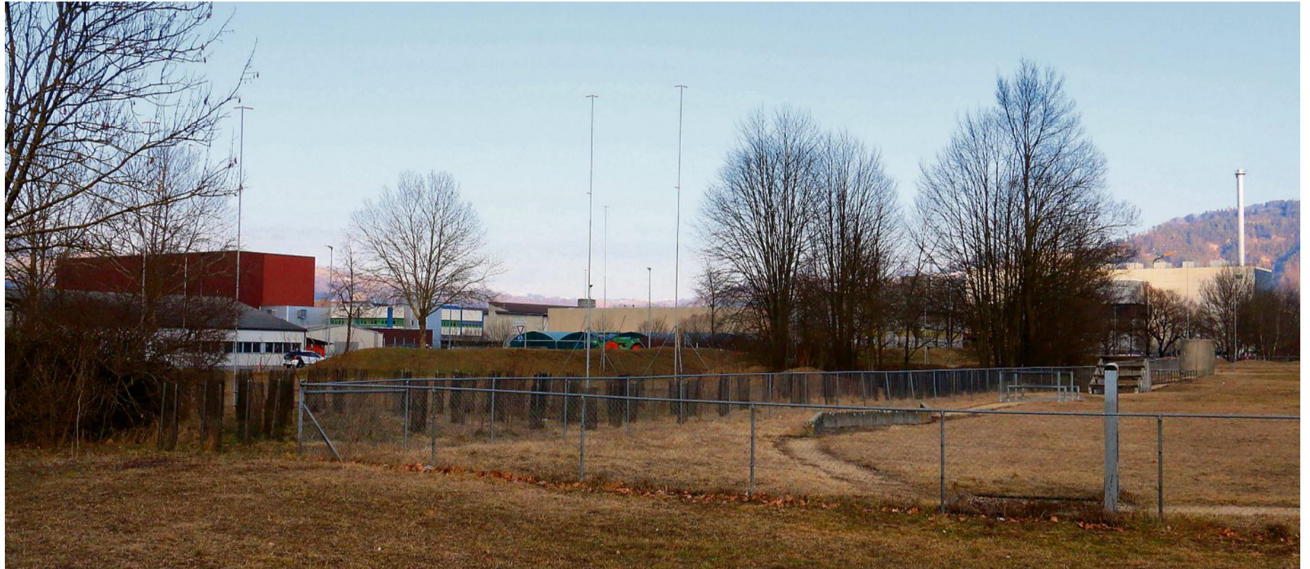
Die Profile deuten die Dimensionen der Neubauten an. Diese lösen Infrastrukturen ab, welche die Armee auf der Kleinen Allmend (im Hintergrund) aufgeben wird. Foto: Andreas Tschopp
