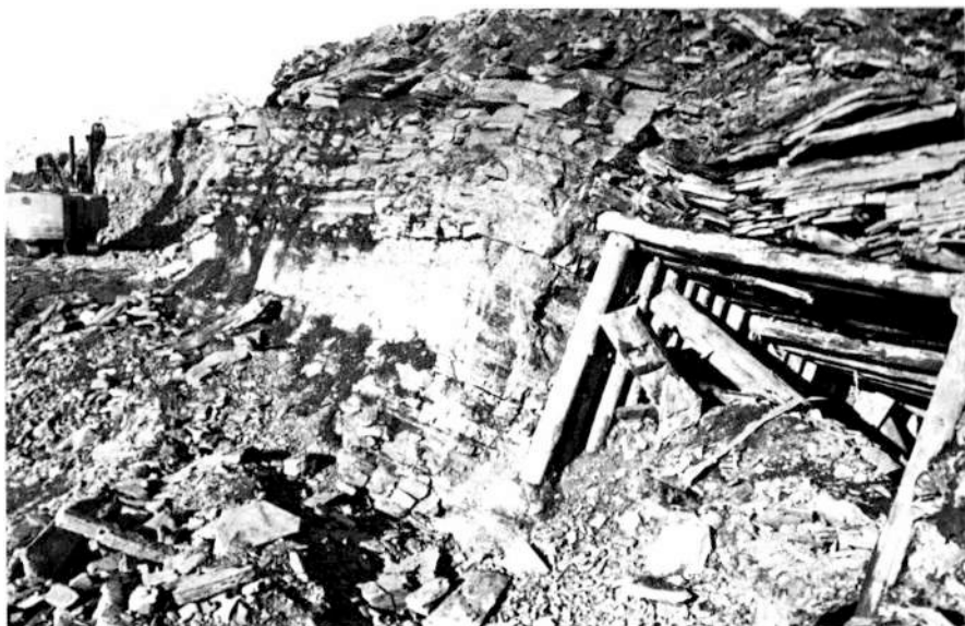
Старая шахтная выработка, вскрытая горными работами разреза "Северный". Фото 1957 г.
