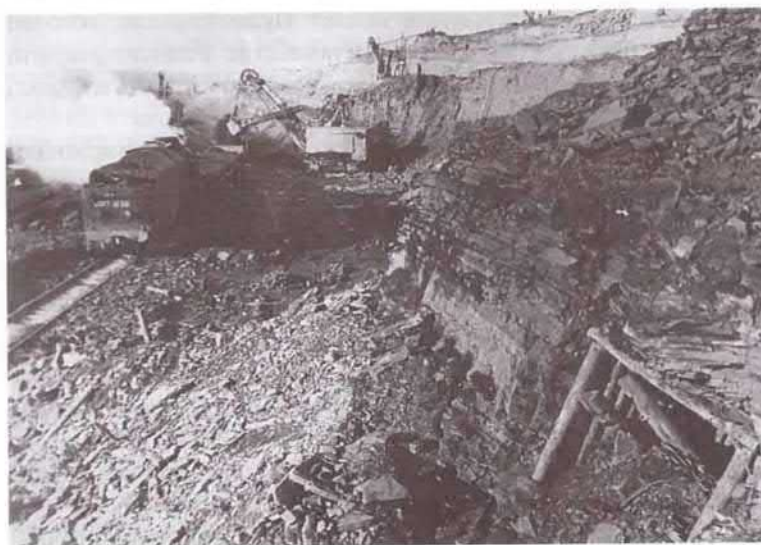
Старая шахтная выработка, вскрытая экскаватором СЭ-3. Фото 1957 г.
