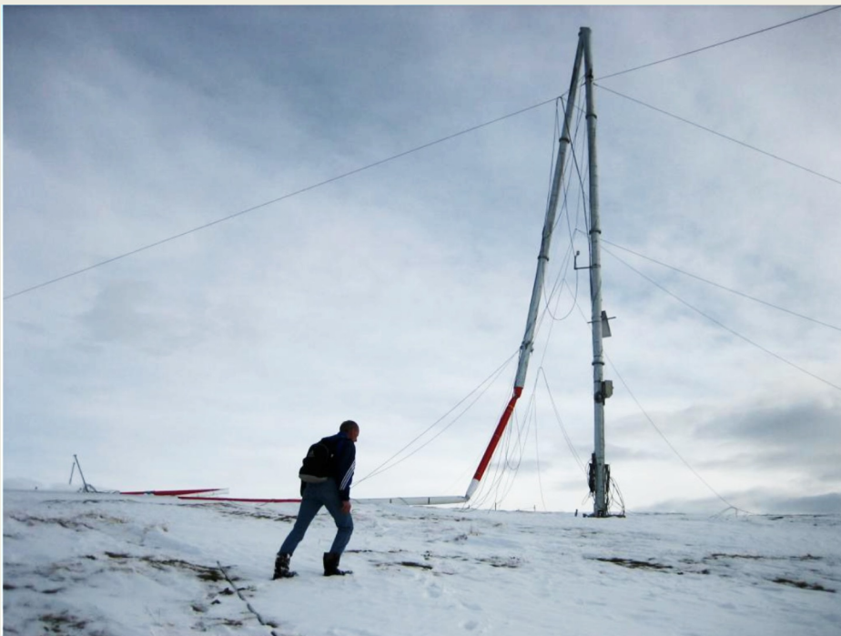
Der Messmast auf dem Schwyberg knickte im November 2007 unter der Last des Eises. © Enco Energy Consulting
