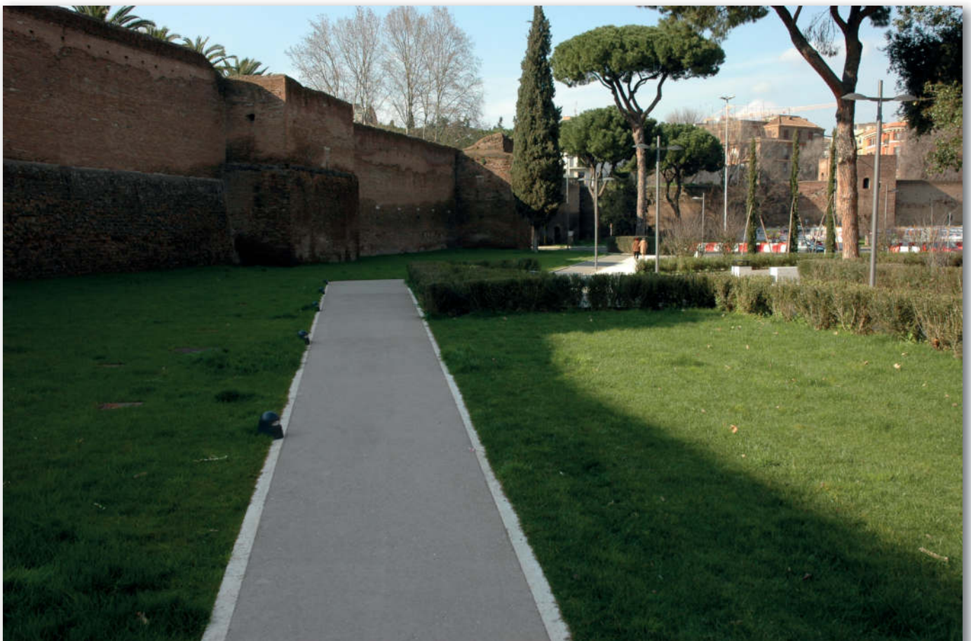
Pavimentazione in terra stabilizzata
