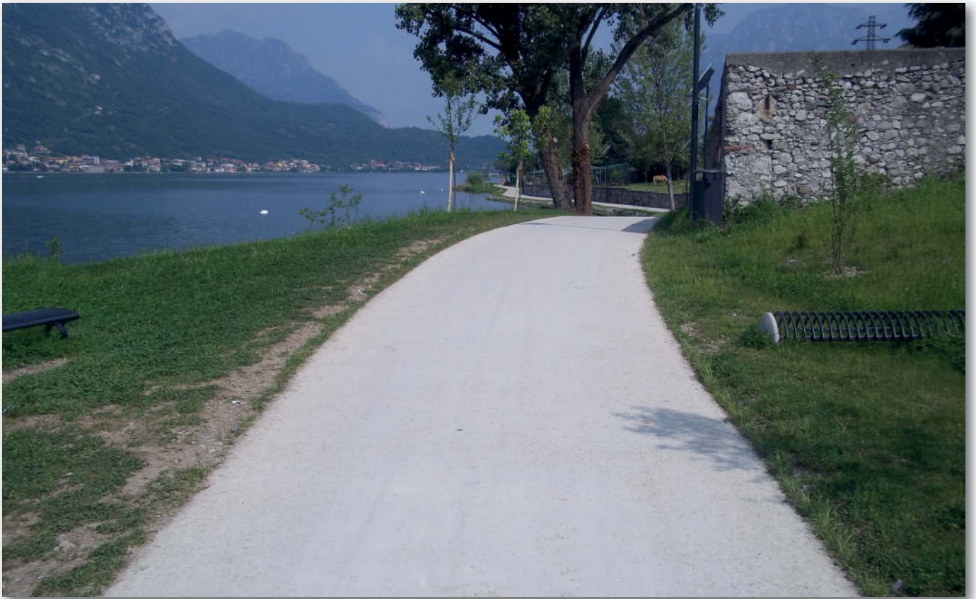
Pavimentazione in terra stabilizzata
