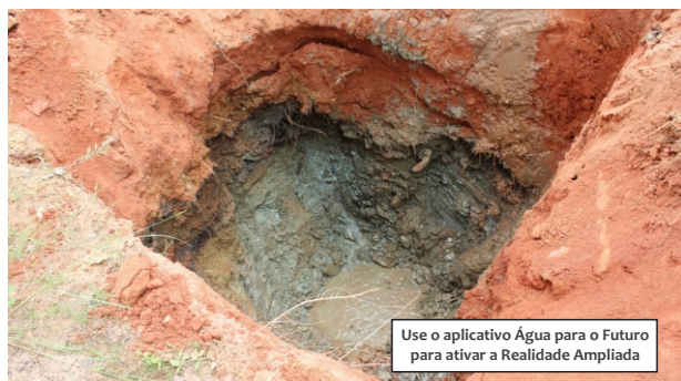
Figura 14 - Abertura de trincheira para a confirmação do aterramento de uma nascente.
