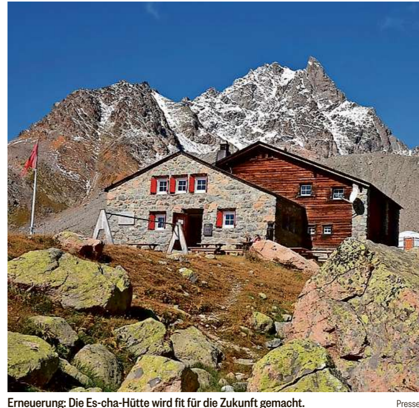
Erneuerung: Die Es-cha-Hütte wird fit für die Zukunft gemacht. Pressebild
