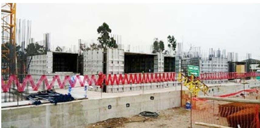
En cuanto a fierro, el complejo requirió 3,680 toneladas de acero en varilla, que fueron habilitadas en obra. Para la construcción de losas se utilizaron mallas electrosoldadas como acero de refuerzo, lo que permitió optimizar los tiempos de habilitación y colocación de acero en losas macizas.
