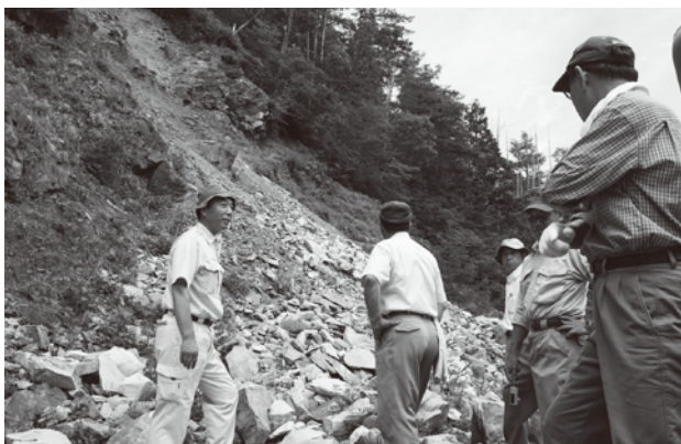
崩れた土砂で覆われたオッ越牧道
