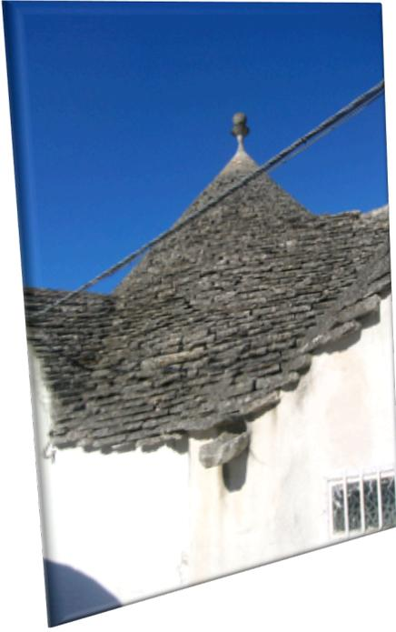
La pianta del trullo è approssimativamente circolare; in genere si tratta di unità modulari con ambienti distribuiti intorno al vano centrale. Lo spessore delle mura e la scarsa presenza di finestre assicurano un **ottimo equilibrio termico**, che assicura tepore in inverno e fresco in estate.
