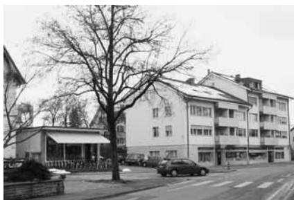
Geschäftszeile an der Nordstrasse 116–118
