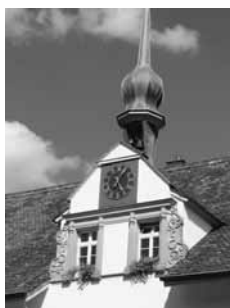
Rietstrasse 1, Restaurant Altes Schützenhaus
