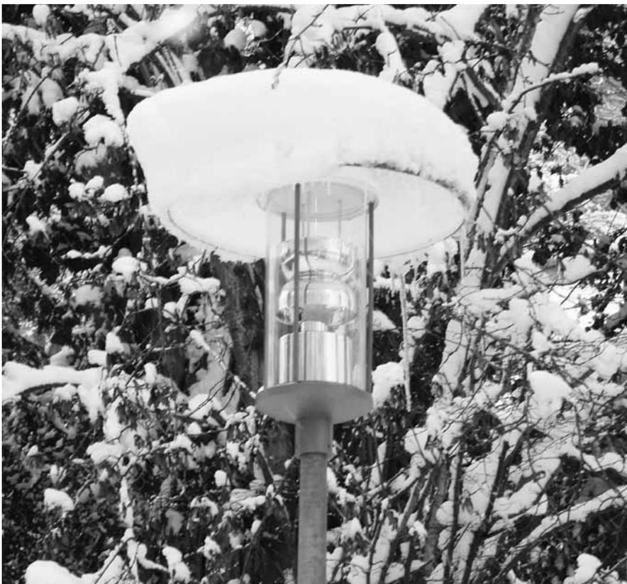
*Unter dem Aspekt einer Reduktion der Lichtemissionen wurden bereits sämtliche Kugel-Leuchten durch neue Parkleuchten ersetzt. Im Rahmen des ordentlichen Unterhalts werden die bauchigen Wannengläser der Strassenleuchten gegen neue Flachgläser ausgetauscht.*
