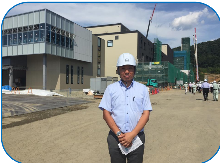
本年4月に本格稼働した甲府・峡東ごみ処理施設「甲府・峡東クリーンセンター」。
