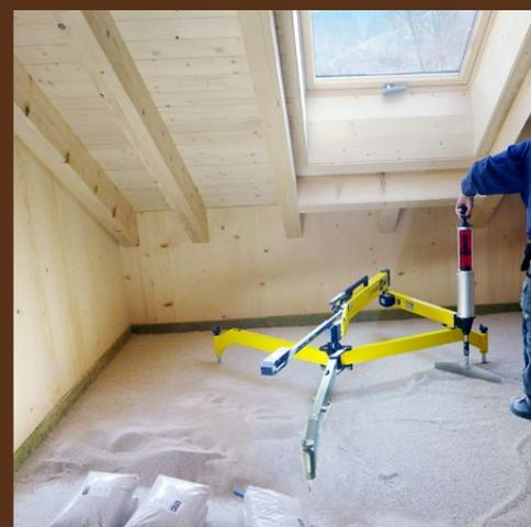
Les granulés calcaires H&F sont déshydratés et séchés. Ils s'utilisent pour le remplissage des éléments de dalles, caissons, en tant que lestage ou comme granulés d'égalisation pour la réalisation de chapes, jusqu'à une hauteur de 100 mm. Ils supportent immédiatement les charges et peuvent être directement foulés.
