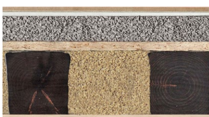
Plafond avec poutres en bois
