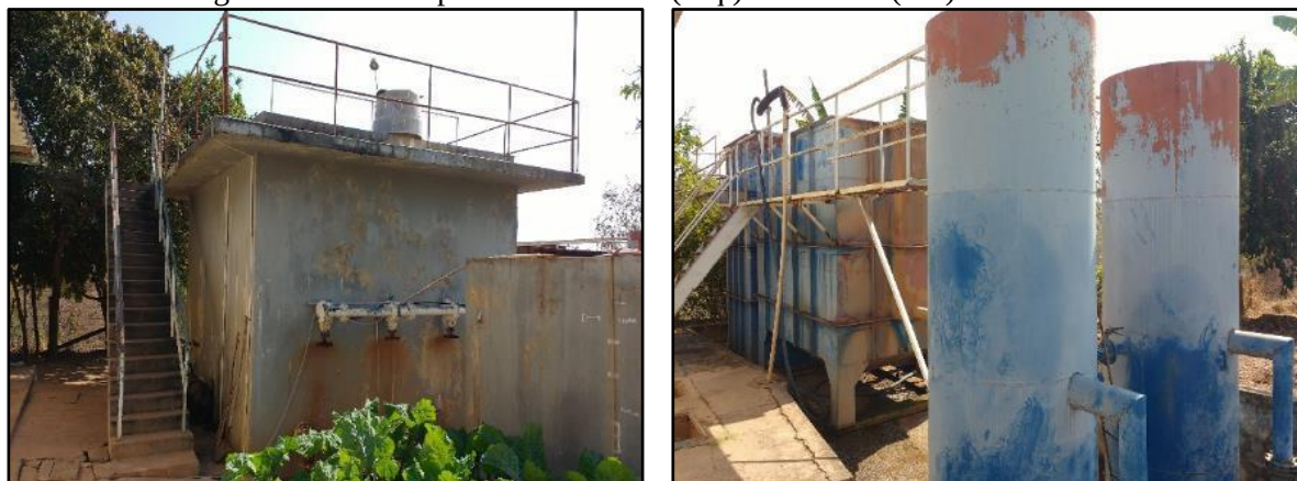
Figura 4. ETA compacta de concreto (esq.) e metálica (dir.) de Torixoréu
