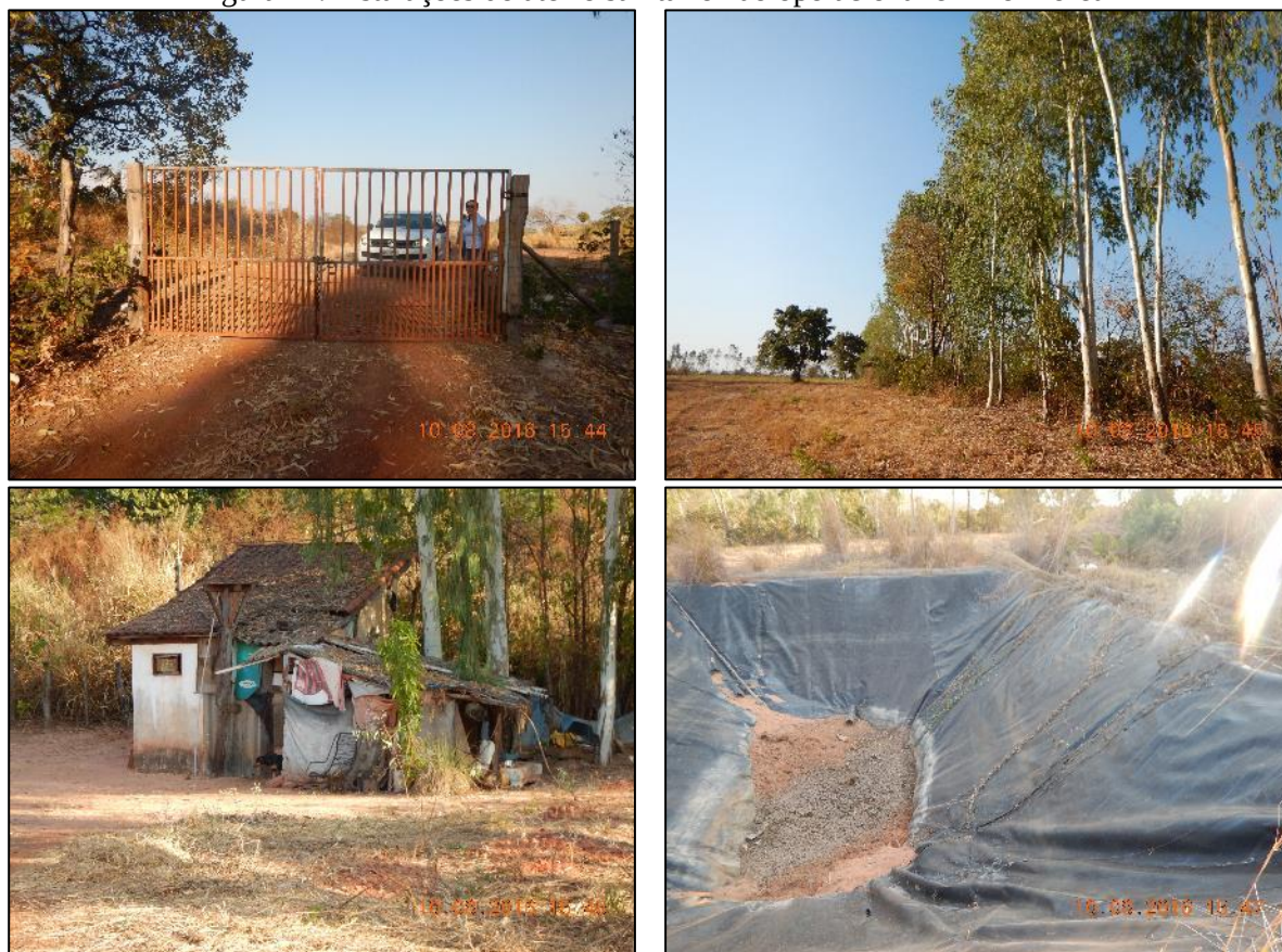
Figura 11. Instalações do aterro sanitário não operacional em Torixoréu
