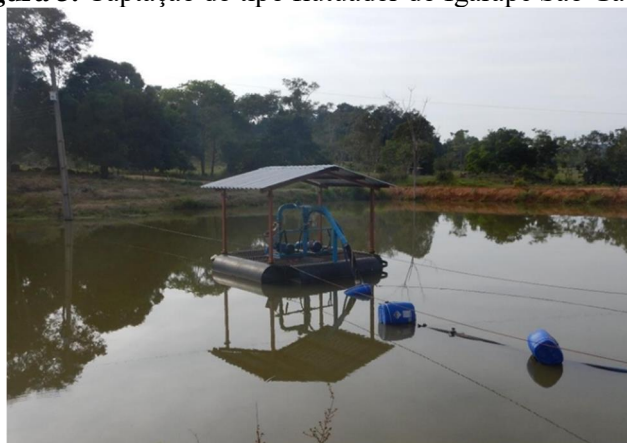
Figura 3. Captação do tipo flutuador do Igarapé São Gabriel
