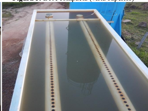
Figura 5. ETA compacta (vista superior)
