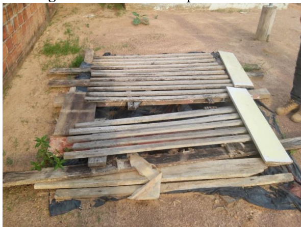
Figura 9. Fossa com tampa danificada
