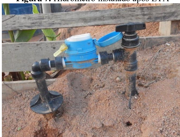
Figura 7. Hidrômetro instalado após ETA
