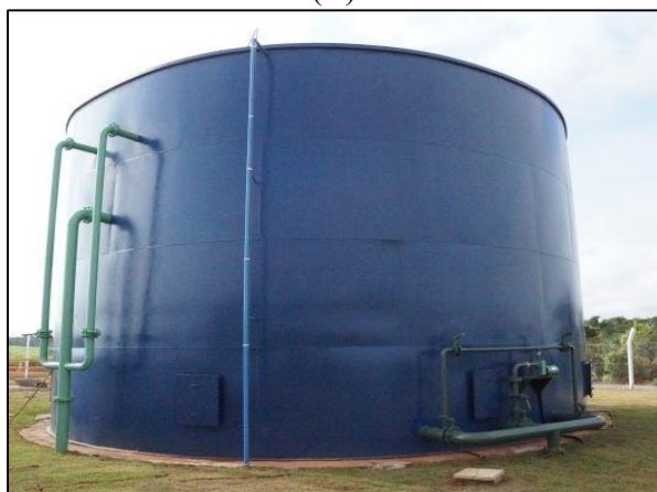
Figura 7. (A) Visão geral do reator UASB (B) Cerca de proteção e portão de acesso na área da ETE
