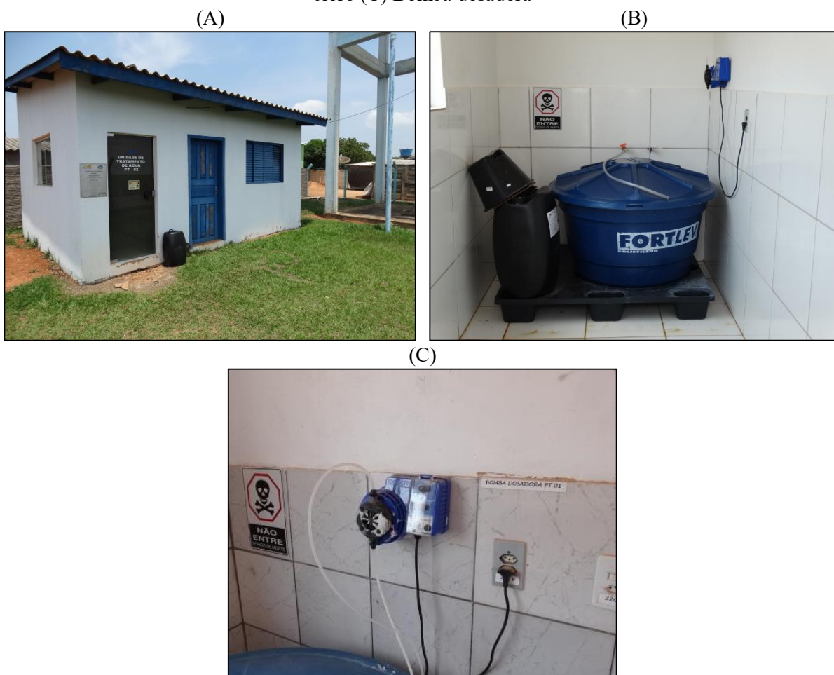
Figura 3. (A) Vista externa da casa de química PT 02 (B) Detalhe do tanque de preparo da solução de cloro (C) Bomba dosadora
