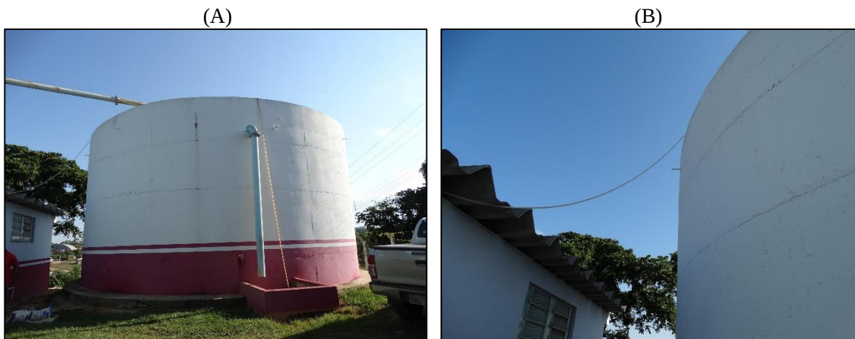
Figura 4. (A) Reservatório – ETA (B) Mangueira flexível para aplicação da cal hidratada no reservatório
