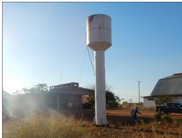
Figura 20. Vista exterior do poço tubular (A) e reservatório metálico elevado (B), ligação de água não hidrometrada (C), Itambiquara
