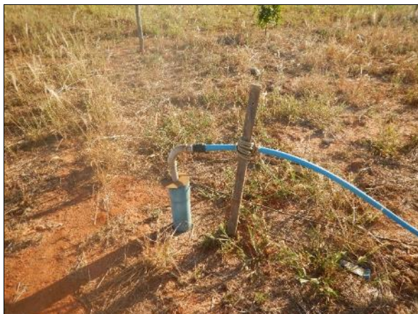
Figura 20. Vista exterior do poço tubular (A) e reservatório metálico elevado (B), ligação de água não hidrometrada (C), Itambiquara
