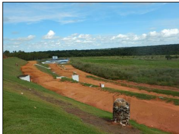
Figura 17. (A) Maciço em uso com compactação dos resíduos (B) Dreno de gases (C) Sistema de tratamento do efluente (D) Poço de monitoramento
