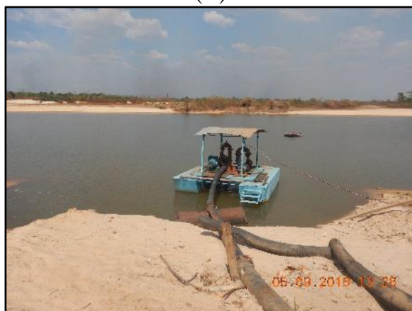
Figura 3. Captação no rio Araguaia (A) e bomba IMBIL(B) (A) (B)
