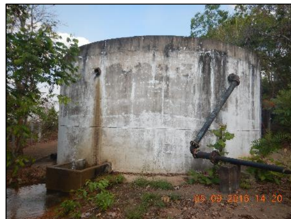
Figura 5. Reservatório ativo do sistema de abastecimento – RAP 01
