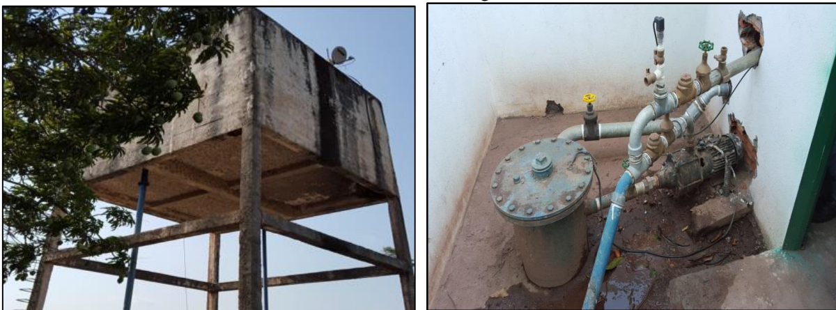
Figura 4. Reservatório na ETA São Sebastião e booster que auxilia no abastecimento do bairro Altos de Jangada
