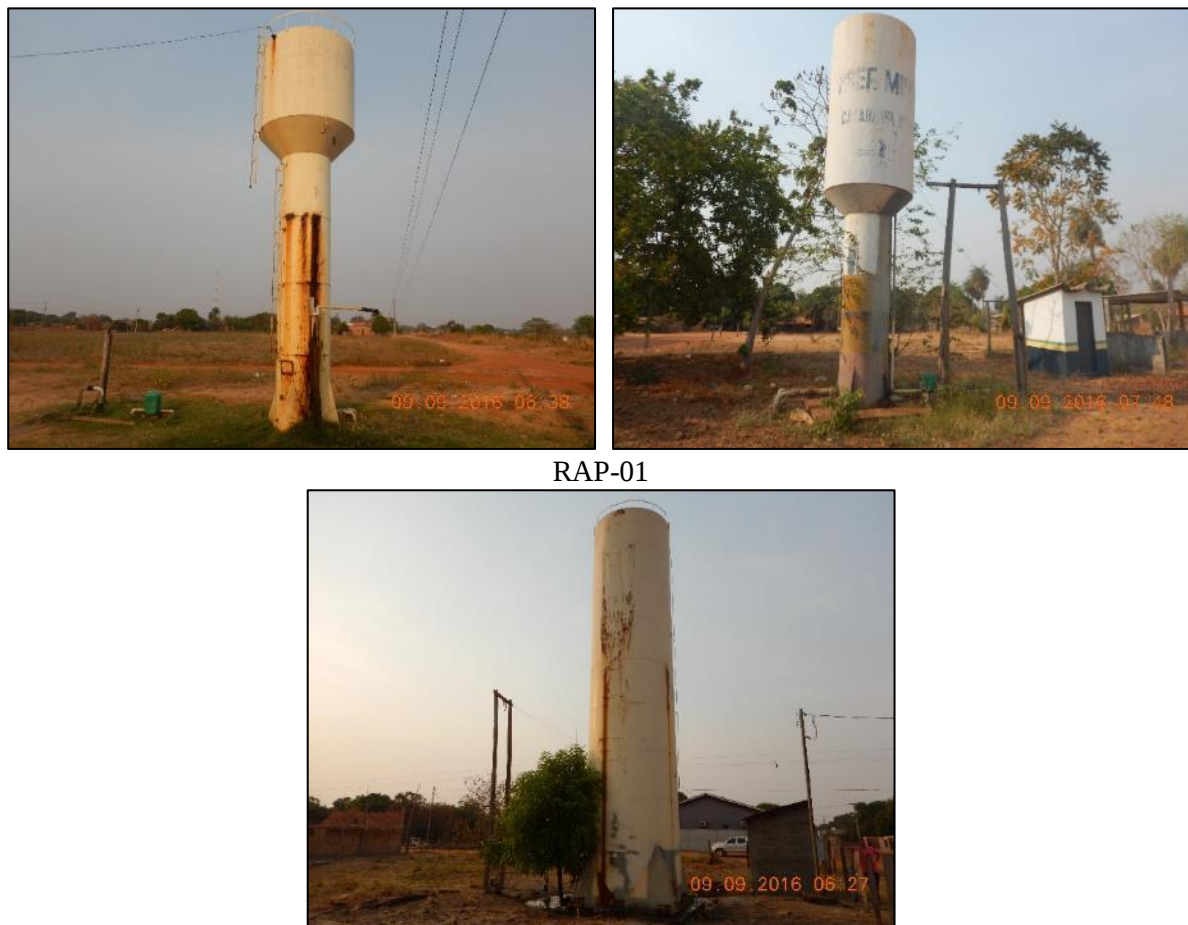
Figura 3. Reservatórios de água e estação pressurizadora do SAA de Canabrava do Norte
