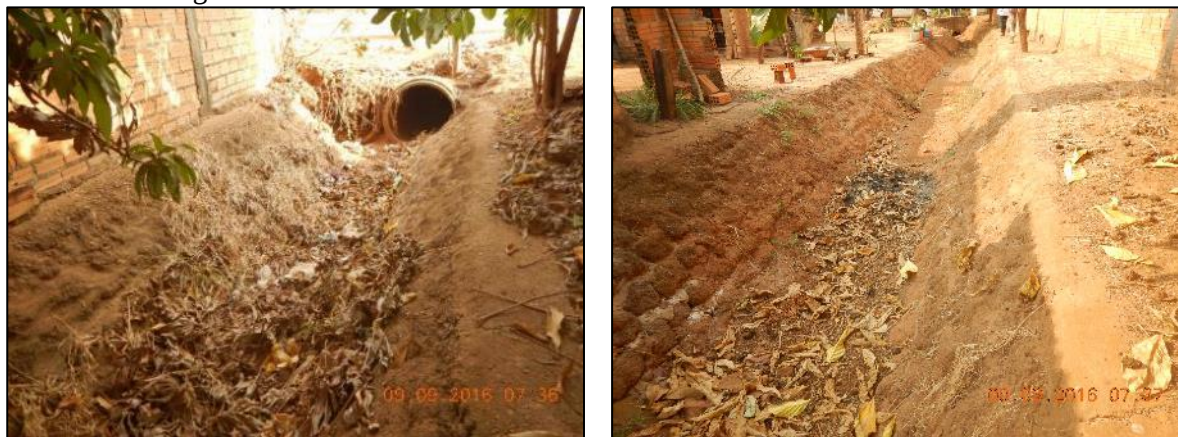
Figura 9. Vista do canal existente na sede urbana de Canabrava do Norte
