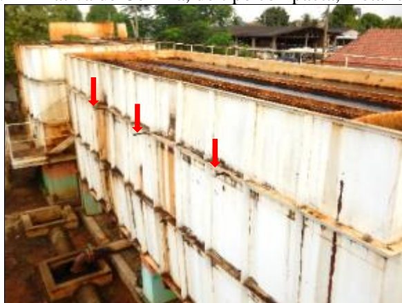
Figura 3. ETA ativa de Colniza, do tipo compacta, metálica e aberta
