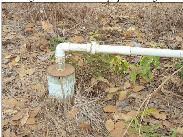
Figura 26. Barrilete do poço de Jaraguá
