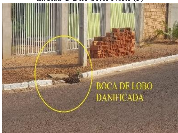
Figura 15. Boca de lobo com tampa danificada na Rua G-2 no Setor Norte (5)
