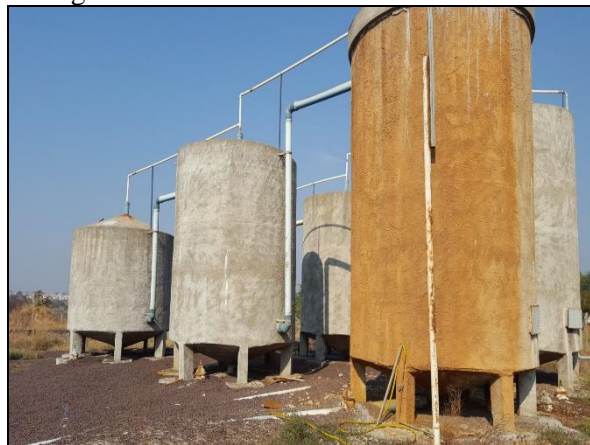
Figura 13. Reatores UASB, seguido por filtros biológicos anaeróbios e decantadores secundários
