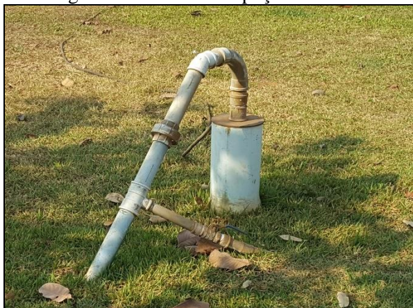
Figura 27. Barrilete do poço de Jandira
