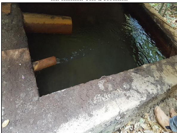
Figura 24. Represamento para captação da água na mina em Serrinha
