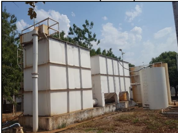
Figura 8. ETA metálica com capacidade para tratar 50 L/s
