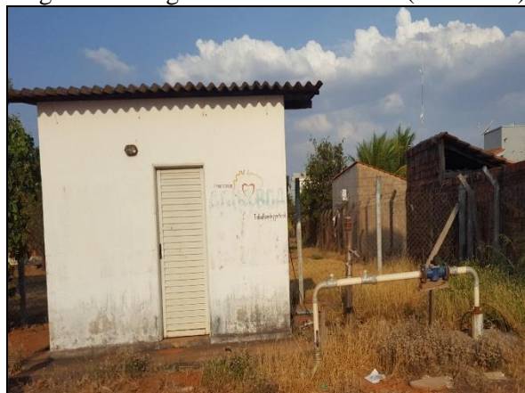
Figura 5. Abrigo e Barrilete do PT-8 (Cristalino)
