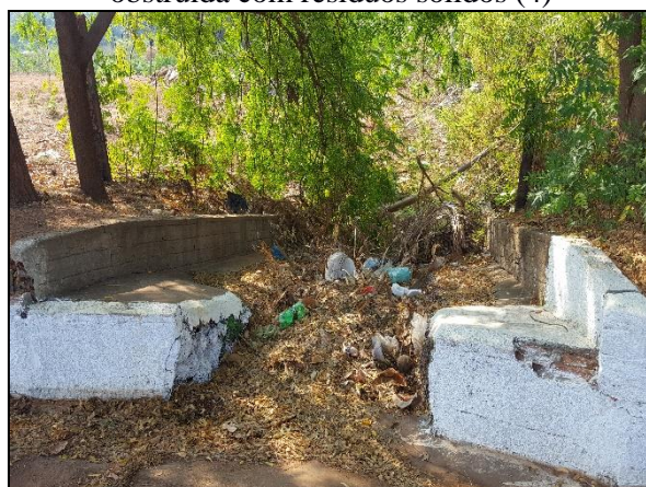
Figura 16. Saída rápida de escoamento superficial obstruída com resíduos sólidos (4)
