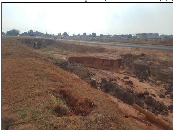
Figura 17. Processo erosivo no canal artificial sem revestimento na Av. Tropical (Setor Industrial) (6)
