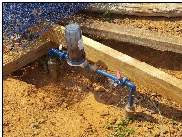
Figura 25. Clorador de passagem inoperante
