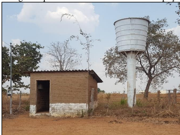
Figura 29. Reservatórios elevado de 10 m 3 em Jaraguá e abrigo do quadro de comando da bomba do poço
