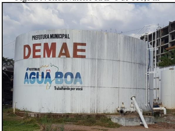
Figura 9. Reservatório RAP-1 de 600,0 m 3
