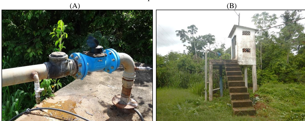
Figura 2. (A) Barrilete do PT da sede urbana de São José do Povo (B) Laje do barrilete do PT e abrigo do clorador e quadro de comando
