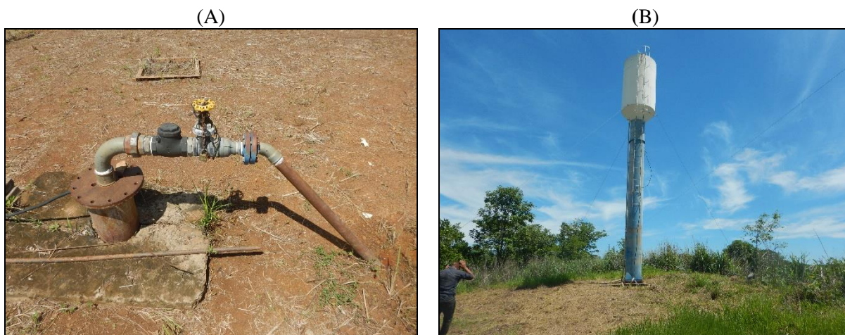
Figura 14. (A) Poço tubular e reservatório de água de 16 m 3 (B) no assentamento Serrinha em São José do Povo
