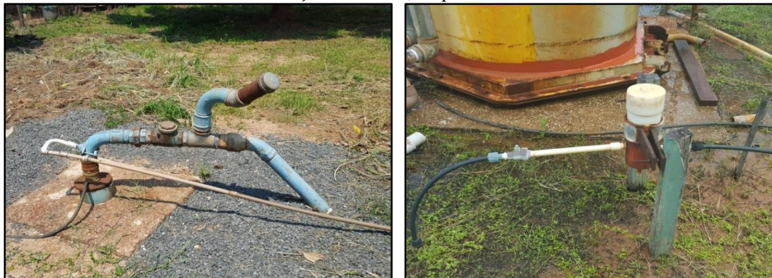
Figura 3. Ramal no barrilete do PT-Centro 02 para alimentação do sistema de desinfecção e Sistema de cloração do PT-05, respectivamente
