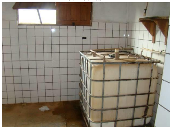
Figura 3. Sistema de tratamento com simples desinfecção por cloração, com mistura preparada em bombonas
