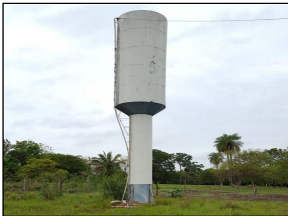
Figura 9. Reservatório tipo taça de 40m 3 (R-02)
