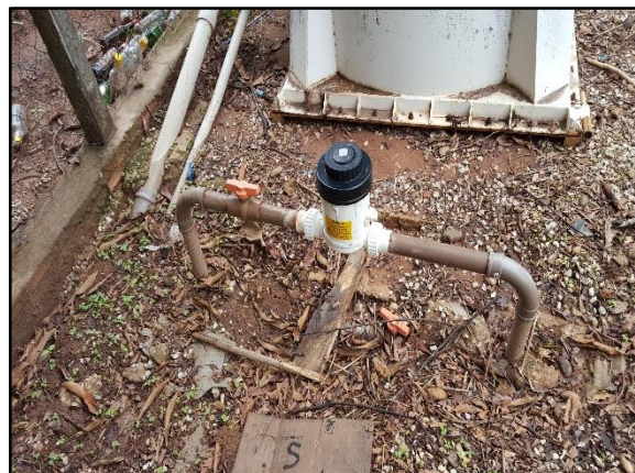
Figura 7. Sistema de cloração do PT-06
