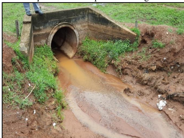
Figura 19. Deságue da galeria de águas pluviais desprovida de dissipador de energia
