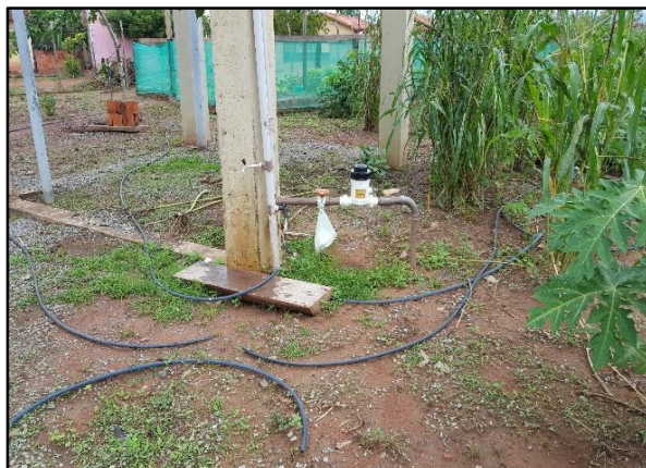
Figura 6. Localização do dosador de cloro na área do REL-01
