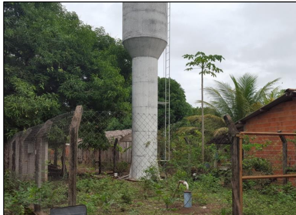
Figura 10. Reservatório tipo taça de 30m 3 (R-03)
