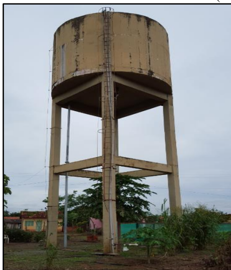
Figura 8. Reservatório elevado de 120 m 3 (REL-01)
