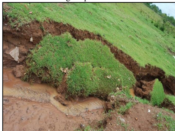
Figura 20. Erosão no ponto de deságue das águas pluviais
