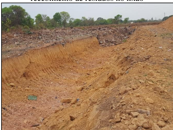
Figura 13. Vala aberta sem proteção do solo para recebimento de resíduos no lixão
