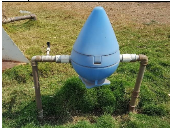
Figura 6. Dispositivo de cloração e fluoretação do tipo contato no barrilete do PT-Cohab
