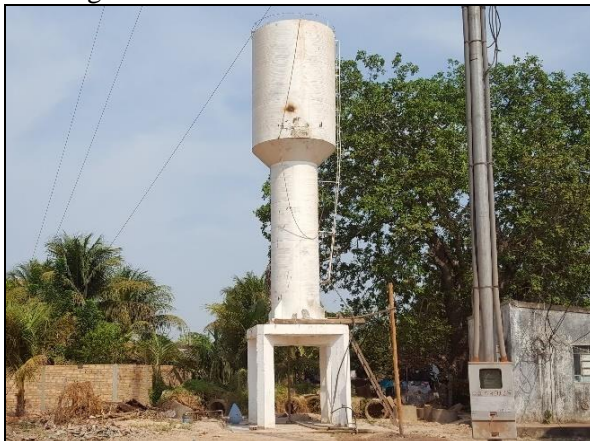
Figura 8. Reservatório REL-02 de 30 m 3
