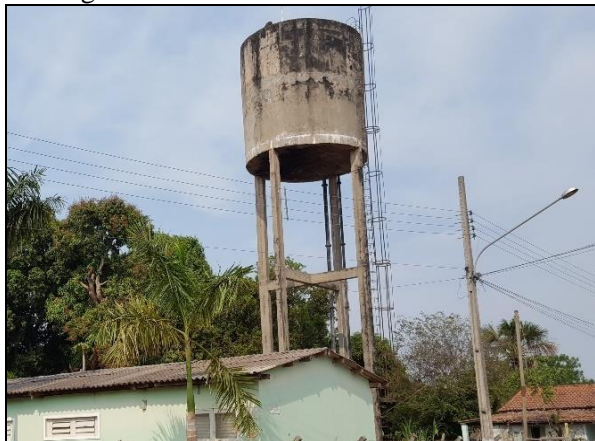
Figura 7. Reservatório REL-01 de 100 m 3
