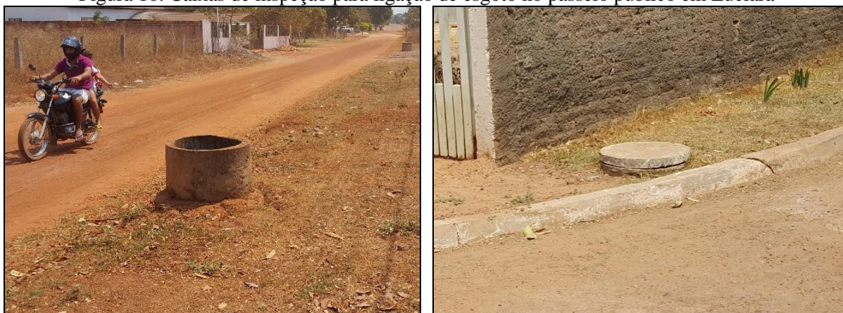
Figura 10. Caixas de inspeção para ligação de esgoto no passeio público em Luciara
