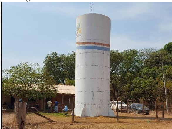
Figura 9. Reservatório RAP-01 de 90 m 3
