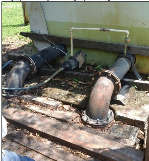
Figura 2. Tubulação no poço de sucção da captação de água bruta de Vale de São Domingos
