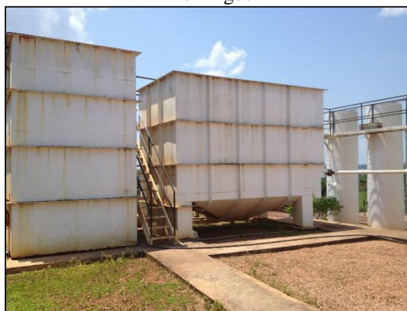
Figura 3. ETA compacta metálica aberta com capacidade de tratamento de 10 L/s em Vale de São Domingos
