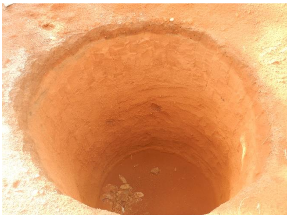
Figura 5. Fossa rudimentar, em construção
