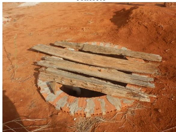
Figura 6. Fossa rudimentar, sem tampa de concreto
