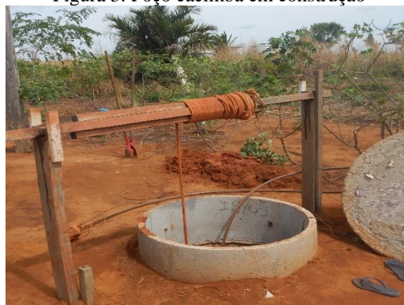
Figura 3. Poço cacimba em construção
