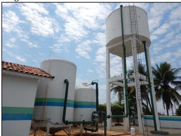
Figura 4. Visão Geral da ETA e do reservatório
