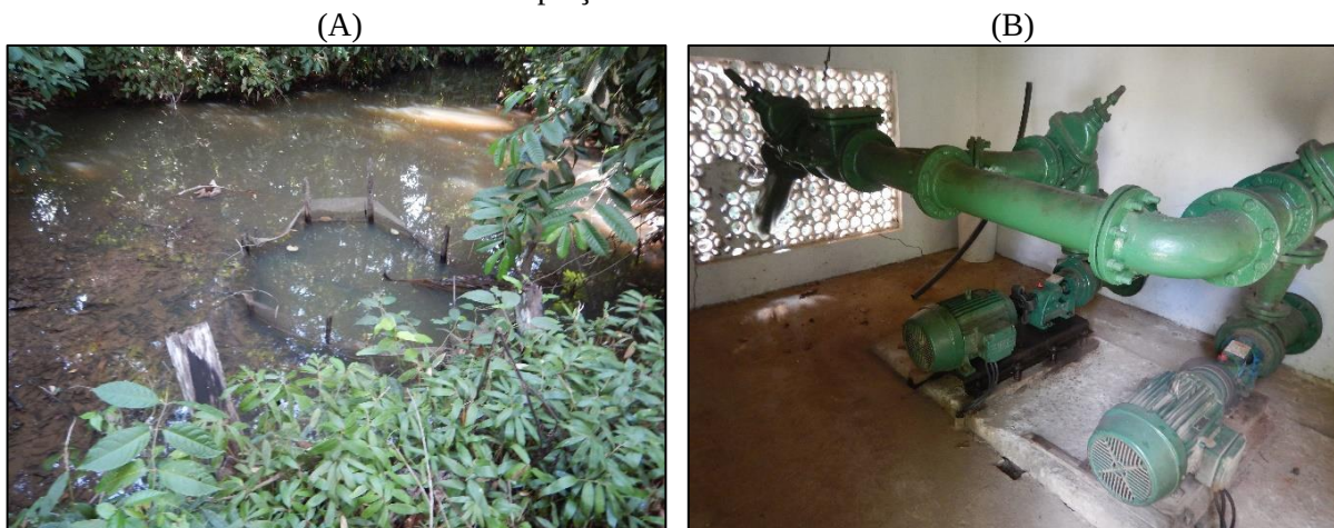
Figura 2. Captação superficial: (A) Ponto de captação de água (B) Bomba principal utilizada na captação e bomba reserva
