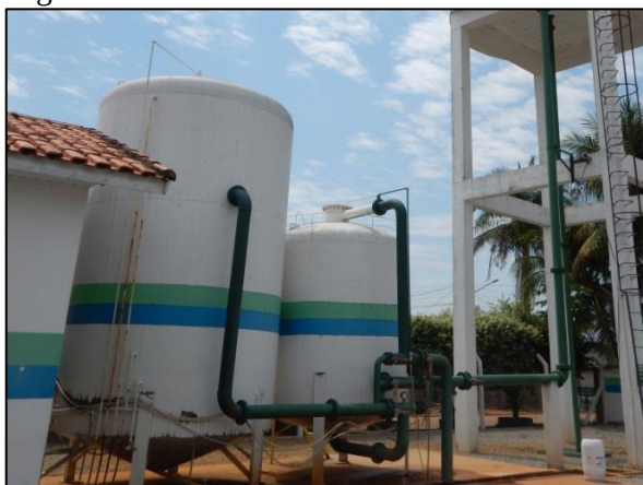
Figura 3. Flocculador e filtro - ETA Carlinda
