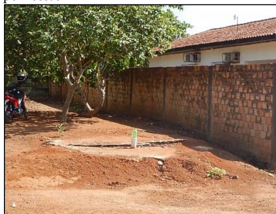
Figura 3. Soluções individuais de esgotamento sanitário adotados em Nova Monte Verde, caracterizado por fossas
