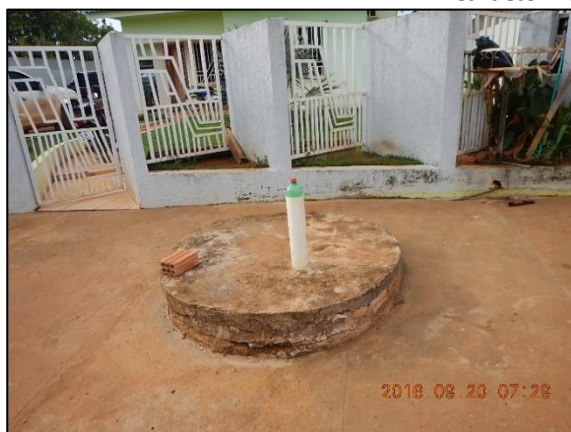
Figura 3. Soluções individuais de esgotamento sanitário adotados em Nova Monte Verde, caracterizado por fossas
