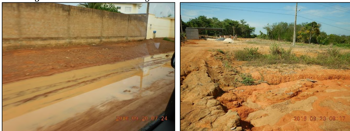
Figura 8. Pontos de acúmulo de água e erosões na área urbana de Nova Monte Verde
