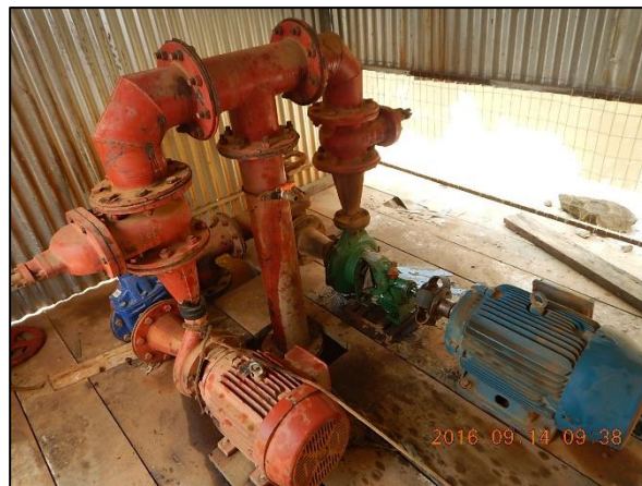
Figura 2. Flutuador utilizada para captação de água no rio São João da Barra (a), e conjuntos motor-bomba principal e reserva utilizados na captação de água (b) em Nova Bandeirantes
