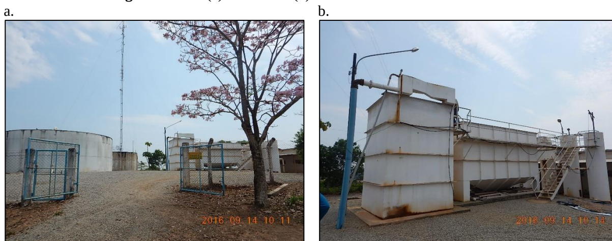
Figura 3. Área (a) e estrutura (b) da ETA de Nova Bandeirantes
