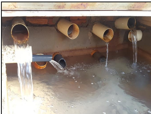
Figura 2. Água captada por tubulações drenantes na mina em Novo Mundo
