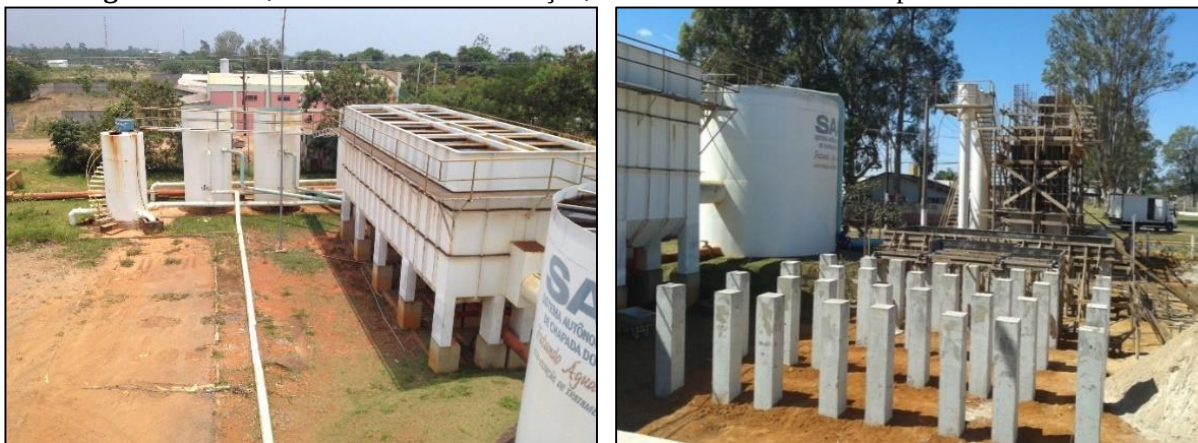
Figura 3. ETAs, existente e em construção, na sede do SAAE de Chapada dos Guimarães
