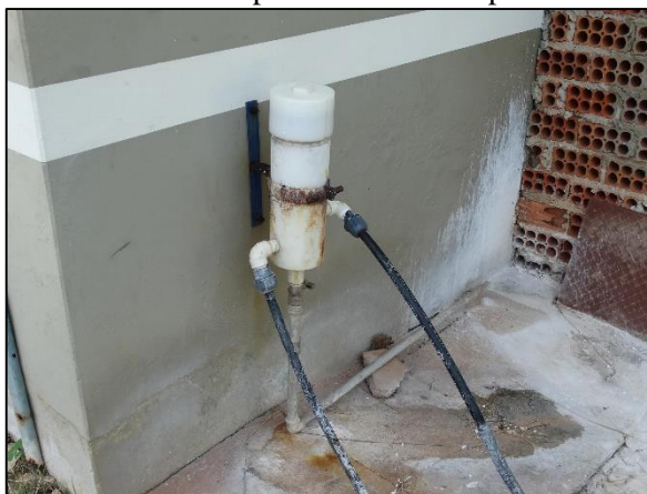
Figura 3. Clorador de pastilha instalado próximo ao R 01
