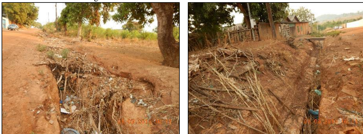
Figura 9. Vias com erosões decorrentes de enxurradas
