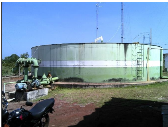
Figura 4. Reservatório RAP – 01, metálico com capacidade de 200 m 3
