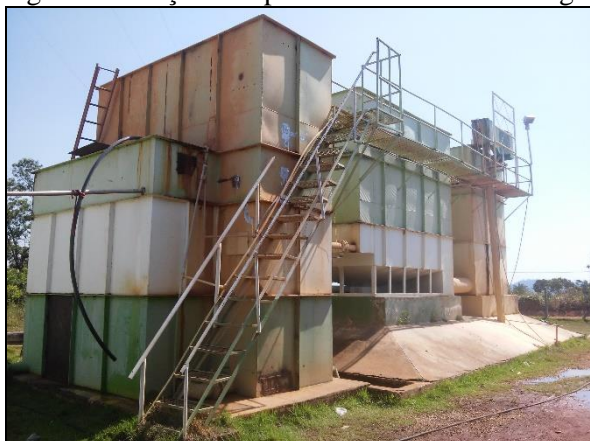
Figura 3. Estação compacta de Tratamento de água
