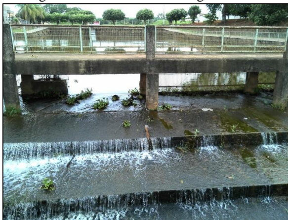
Figura 10. Sistema de gradeamento na saída do lago Pedra Cantante em Juscimeira
