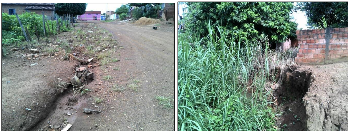
Figura 13. Erosões em ruas não pavimentadas e Problemas de erosão e desbarrancamento do córrego das Lavadeiras
