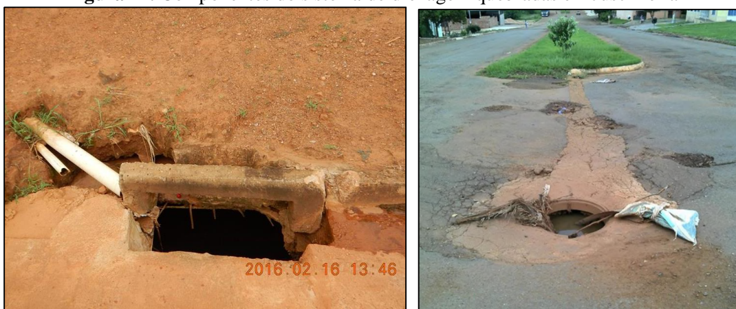
Figura 14. Componentes do sistema de drenagem quebradas em Juscimeira
