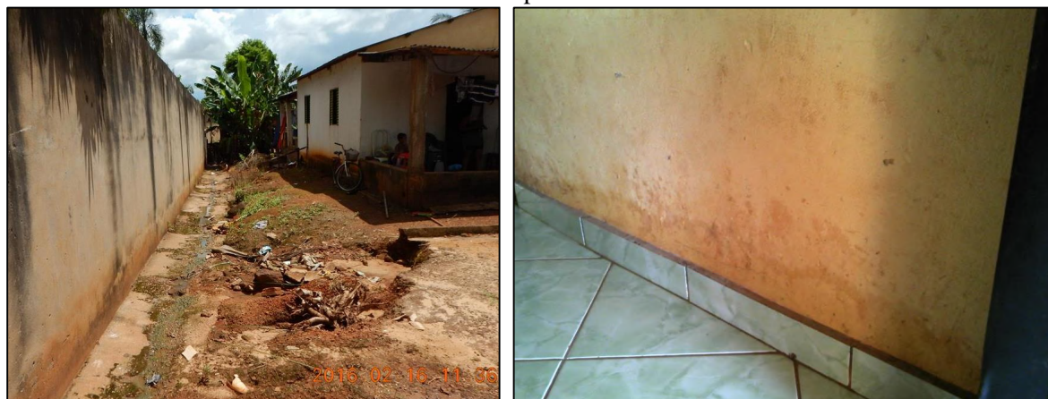
Figura 16. Marcas deixadas pela água em parede de residência próxima ao balneário e os problemas de erosão provocados
