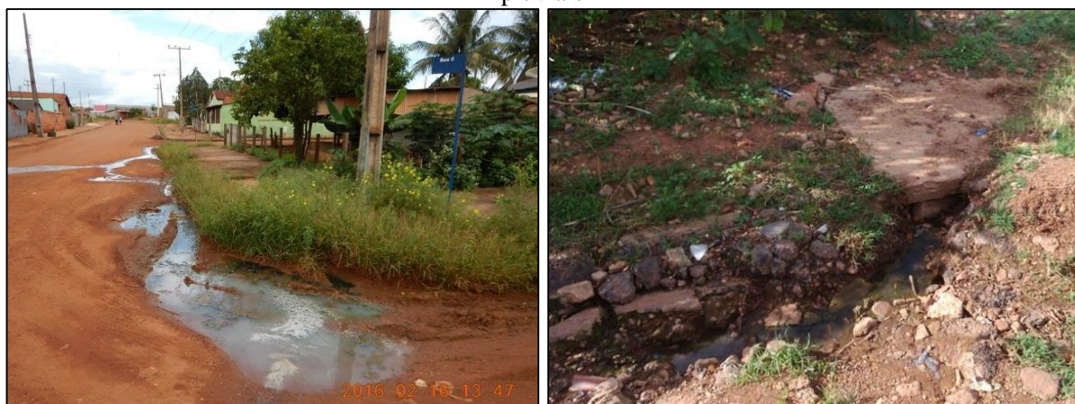
Figura 6. Esgoto correndo a céu aberto nas ruas de Juscimeira, e caindo na rede de drenagem de águas pluviais
