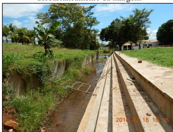
Figura 8. Córrego Águas Claras canalizado na região do balneário de águas quentes, com desbarrancamento da margem
