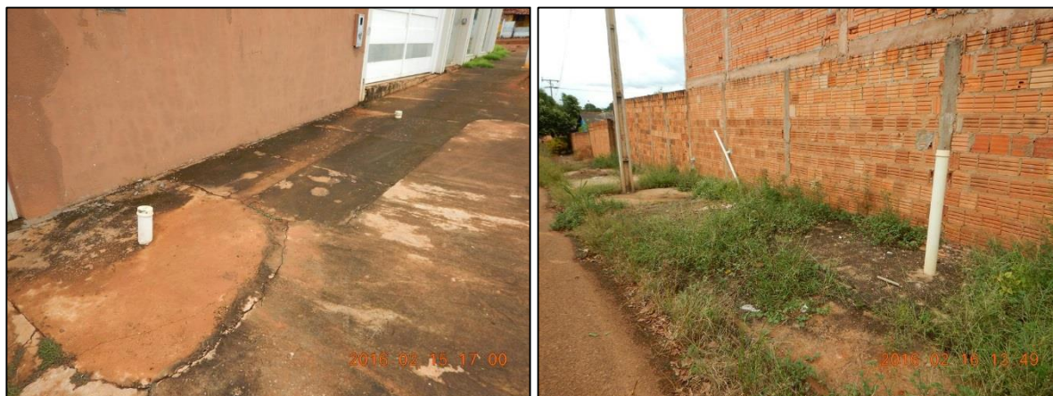
Figura 5. Soluções individuais de esgotamento sanitário adotados em Juscimeira, caracterizado por fossas
