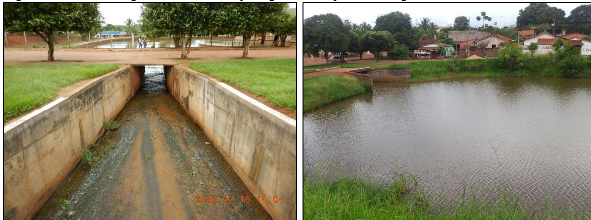
Figura 9. Canal retangular de concreto que liga as duas partes do lago Pedra Cantante em Juscimeira
