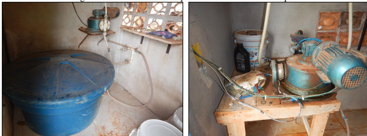
Figura 3. Sistema de desinfecção e bomba dosadora em Sapezal
