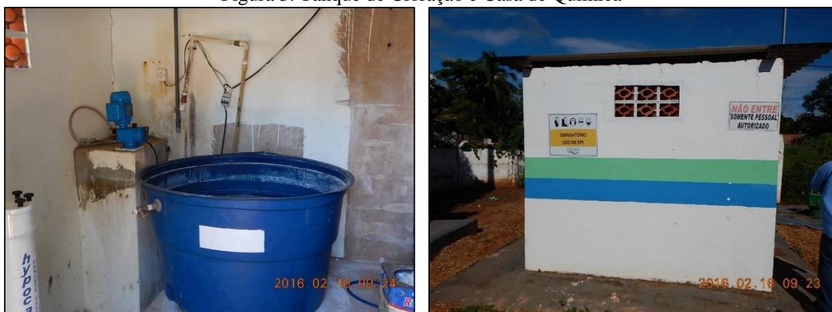
Figura 3. Tanque de Cloração e Casa de Química
