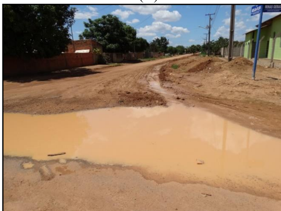
Figura 6. Processos erosivos registrados no bairro Jardim das Palmeiras (A) Acúmulo de água nos processos erosivos (B) Erosão do pavimento no entorno da caixa de inspeção
