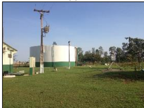
Figura 3. Vista geral da Estação de Tratamento de Água (A) Vista da parte externa (B) Vista da parte interna (C) Reservatório apoiado metálico de 1.000 m 3
