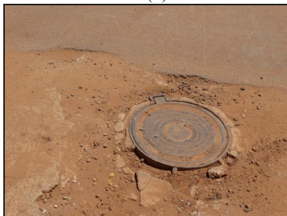
Figura 6. Processos erosivos registrados no bairro Jardim das Palmeiras (A) Acúmulo de água nos processos erosivos (B) Erosão do pavimento no entorno da caixa de inspeção
