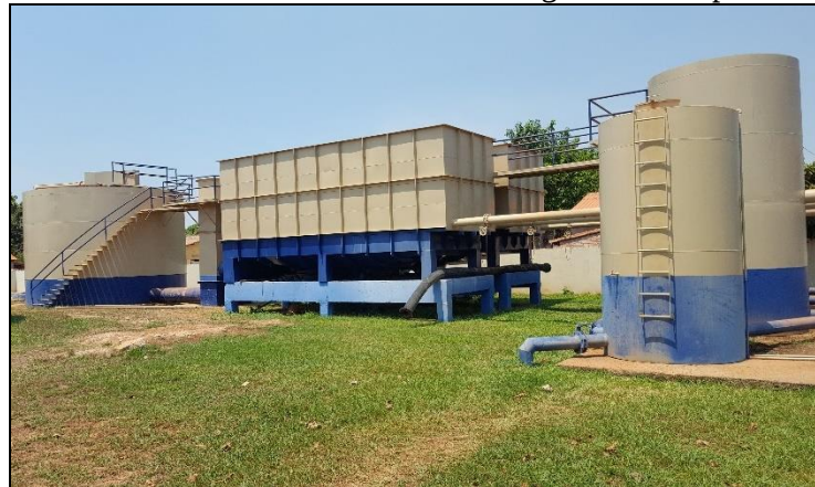
Figura 3. ETA metálica da sede urbana de São Félix do Araguaia com capacidade nominal de 20 L/s
