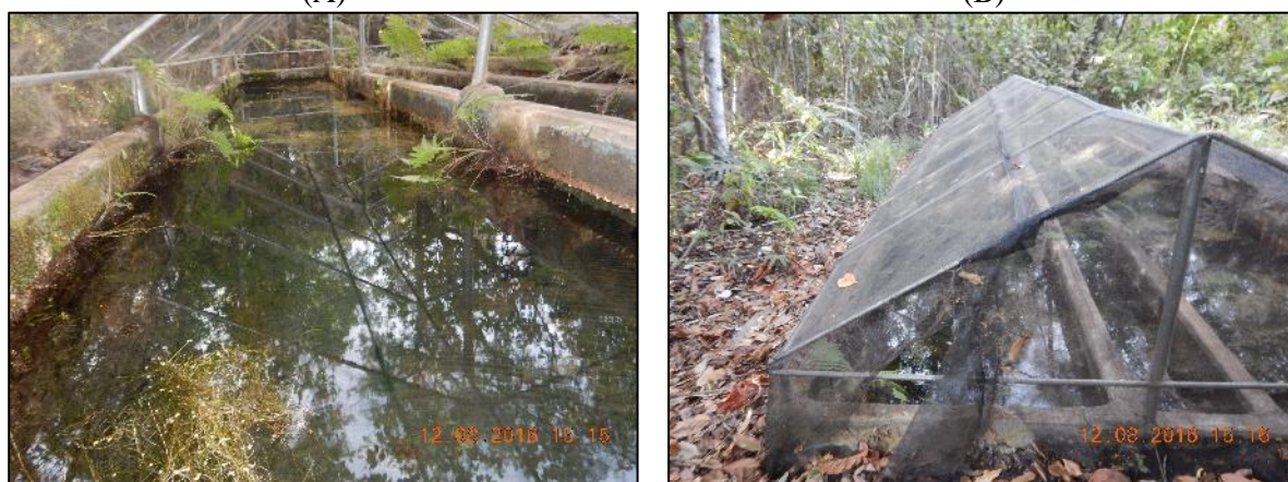
Figura 3. Caixa de acumulação da mina d'água (A), cobertura e tela de proteção (B)
