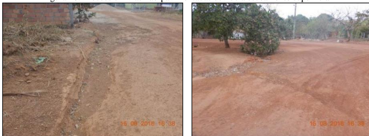
Figura 10. Erosões em vias não-pavimentadas devido a escoamento superficial
