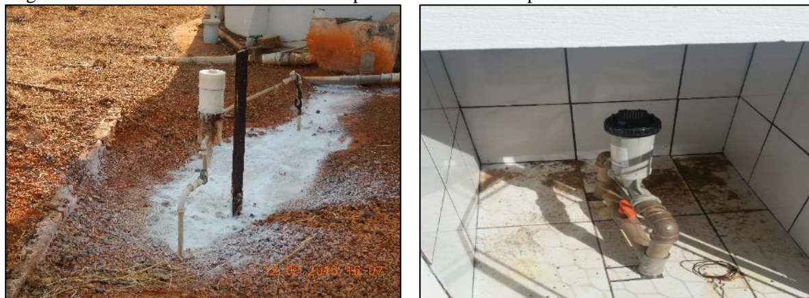
Figura 6. Cloradores de contato existentes para o tratamento simplificado no SAA de Ribeirãozinho
